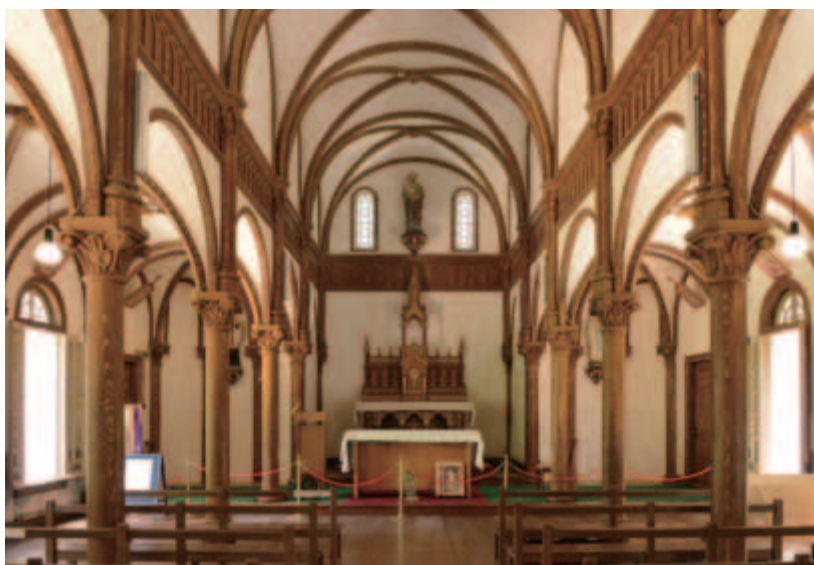
写真 2-116 江上天主堂の内観 3 廊式平面で、アーケード・擬似トリフォリウム・壁付アーチを伴い、天井はリブ・ヴォールトである。
