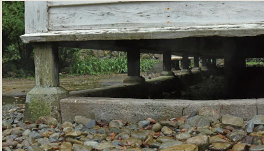
Pour parer aux problèmes d'humidité, le niveau du plancher de l'église d'Egami est plus élevé.
