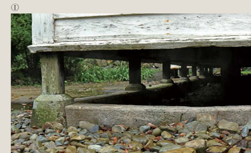
Piso elevado construído para prevenir a humidade
